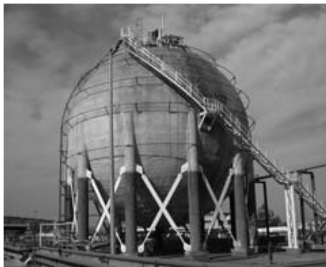
Figura 5: Esempio di serbatoio sferico dotato di un sistema di controvento (terminal di Aspropyrgos , Grecia).
