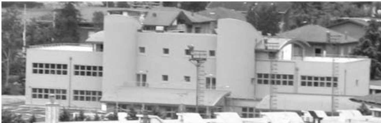
Figura 1: La nuova scuola di Marzabotto (BO), isolata sismicamente (con la collaborazione dell'ENEA) mediante 42 isolatori di 500 mm di diametro, di cui 28 elastomerici ad alto smorzamento ( High Damping Rubber Bearing o HDRB) e 14 con superfici a scorrimento piane acciaio-teflon ( Sliding Device o SD). Il certificato di collaudo in corso d'opera è stato rilasciato dallo scrivente il 6 settembre 2010.
