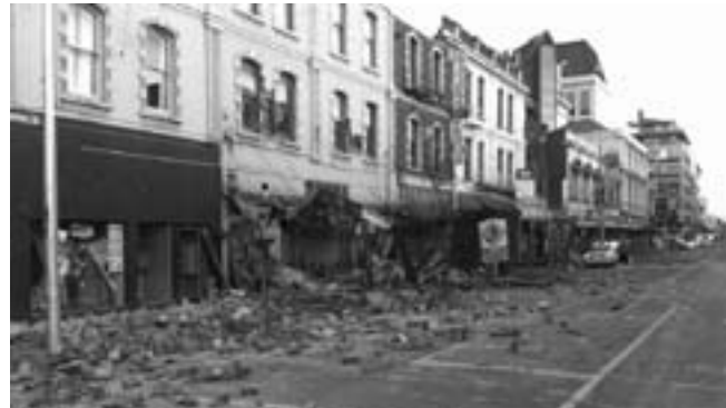
Figure 8 e 9: Danni causati ad edifici fondati convenzionalmente a Christchurch (Nuova Zelanda) dal terremoto di Canterbury del 3 settembre 2010 (M=7,1).
