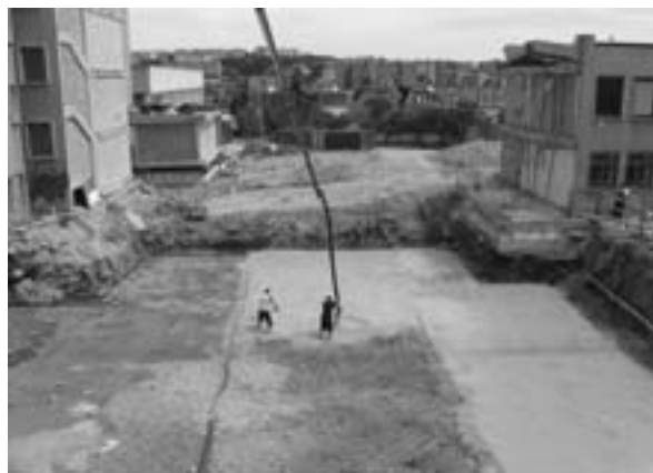
Figura 17: Il liceo di Figura 16 in luglio 2010, dopo la demolizione dei due corpi di fabbrica "A" e "B", rivelatisi i più insicuri a seguito delle indagini sui materiali di costruzione effettuate (con la collaborazione dell'ENEA) dopo il terremoto del Molise e della Puglia del 2002.
