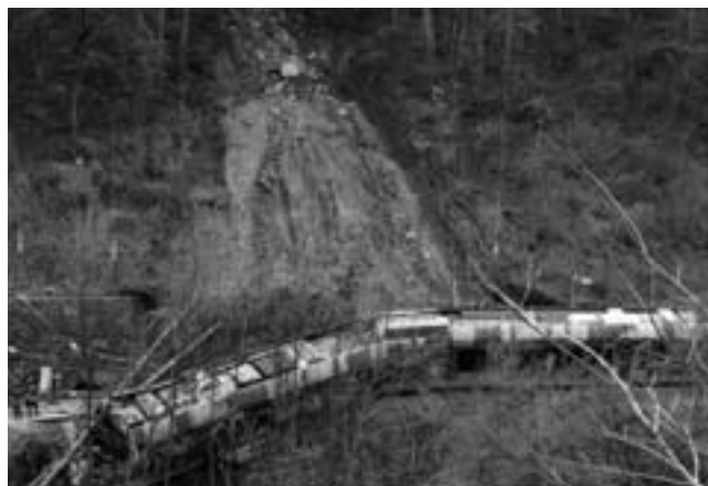
Figura 2: Frana e deragliamenti lungo la linea ferroviaria Malles-Merano (BZ) (Foto gentilmente fornita da A. Zischg).
