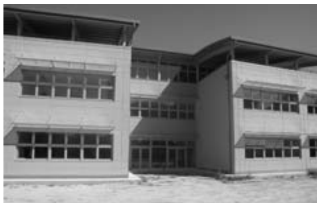
Figura 3: Vista dal retro della nuova scuola isolata di Figura 1. Data l'assenza di giunti strutturali trasversali tutt'attorno all'edificio, per assicurare il libero spostamento orizzontale di progetto (250 mm) ed il conseguente piccolo abbassamento verticale della sovrastruttura isolata, è stato necessario prescrivere che (fino all'avvenuta realizzazione dei giunti trasversali, raccomandata nel certificato di collaudo) il livello del terreno resti più basso di quello della sommità della parete di contenimento del terreno realizzata sotto alla soletta di base della sovrastruttura stessa e da essa separata da un giunto verticale (protetto da un lamierino verticale).
