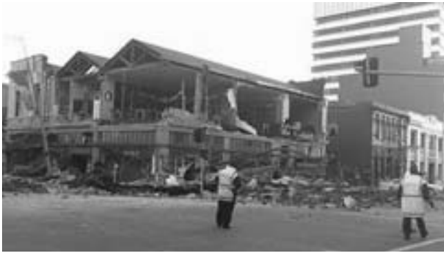
Figure 8 e 9: Danni causati ad edifici fondati convenzionalmente a Christchurch (Nuova Zelanda) dal terremoto di Canterbury del 3 settembre 2010 (M=7,1).
