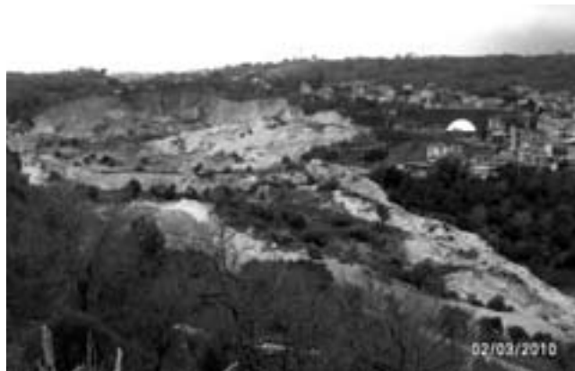
Figura 1: Frana di Maierato (Calabria). (Foto gentilmente fornita da V. Comerchi).
