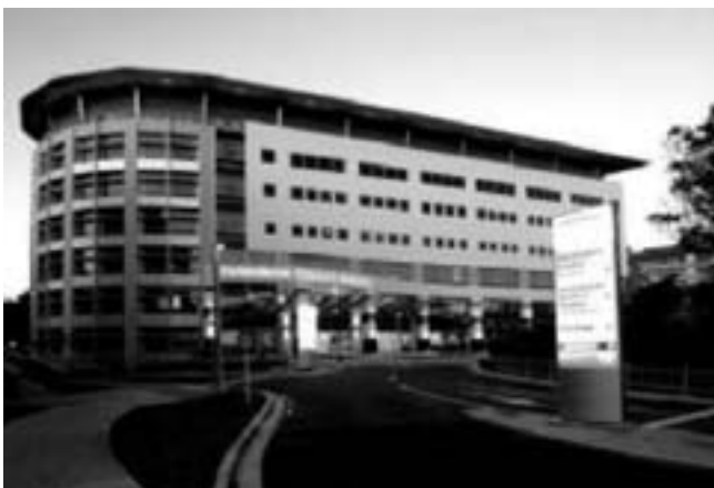
Figura 10: Il Christchurch Woman's Hospital (Nuova Zelanda), isolato sismicamente, che ha resistito indenne al terremoto di Canterbury del 3 settembre 2010 (M=7,1).
