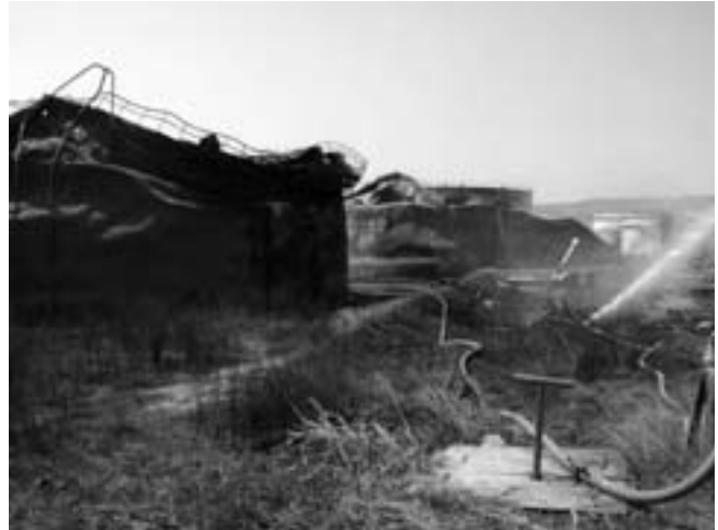
Figura 1: Terremoto di Izmit (Turchia, 1999) – Danni da incendio.
