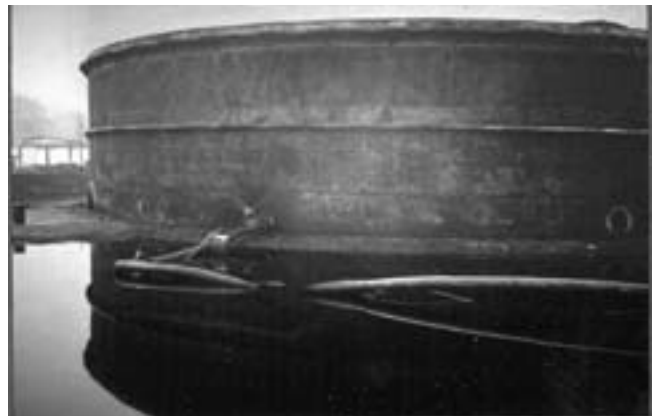
Figura 2: Terremoto in Costa Rica (1991) – Perdita di liquidi.
