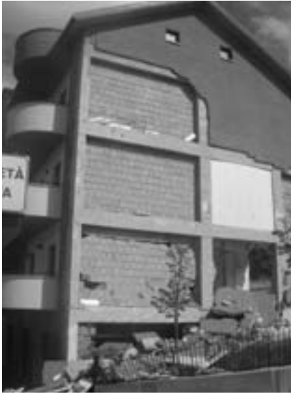
Figure 13-15: Danni provocati all'edificio di Figure 11 e 12 dal terremoto dell'Abruzzo del 6 aprile 2009. È previsto l'adeguamento mediante isolamento sismico, su progetto del socio del GLIS e dell'ASSISi ing. Giuseppe Mancinelli e con collaudo in corso d'opera dello scrivente.
