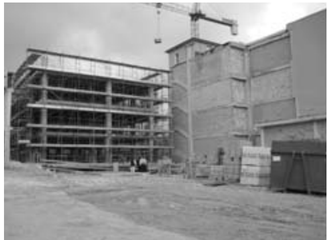
Figura 21: Stato della ricostruzione del nuovo corpo di fabbrica "B" del liceo di Figura 16, in ottobre 2010 (a fianco dell'originario corpo "C", caratterizzato da materiali migliori e, quindi, non demolito, per il quale si raccomanda l'adeguamento con isolamento sismico).
