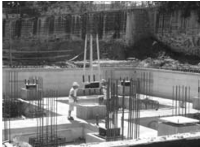
Figura 19: Posa degli isolatori sismici (12 HDRB di 650 mm di diametro e 10 SD di 600 mm di diametro) nel vano interrato nel nuovo corpo di fabbrica "B" del liceo di Figura 16, l'unico già in fase di ricostruzione.
