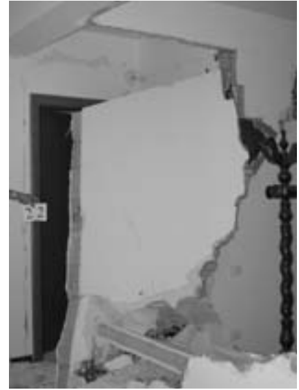
Figure 13-15: Danni provocati all'edificio di Figure 11 e 12 dal terremoto dell'Abruzzo del 6 aprile 2009. È previsto l'adeguamento mediante isolamento sismico, su progetto del socio del GLIS e dell'ASSISi ing. Giuseppe Mancinelli e con collaudo in corso d'opera dello scrivente.
