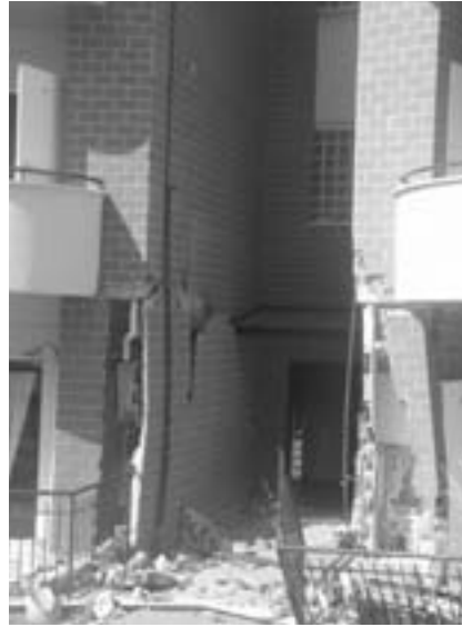
Figure 13-15: Danni provocati all'edificio di Figure 11 e 12 dal terremoto dell'Abruzzo del 6 aprile 2009. È previsto l'adeguamento mediante isolamento sismico, su progetto del socio del GLIS e dell'ASSISi ing. Giuseppe Mancinelli e con collaudo in corso d'opera dello scrivente.
