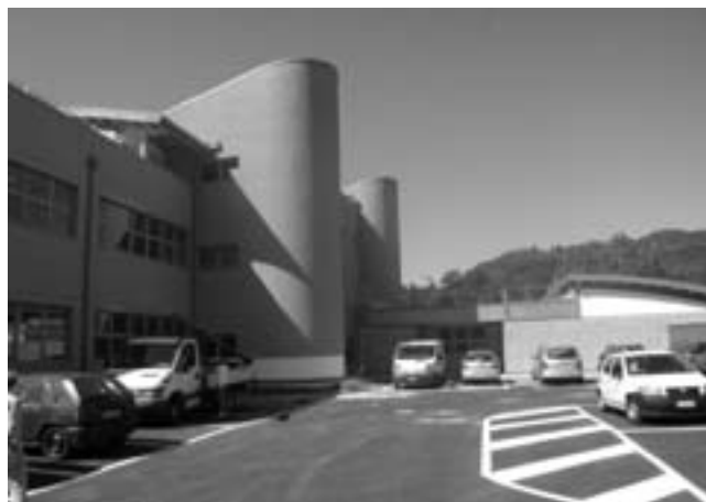
Figura 2: Particolare della nuova scuola di Figura 1. Nel certificato di collaudo si è raccomandata l'installazione di un adeguato sistema di monitoraggio sismico.
